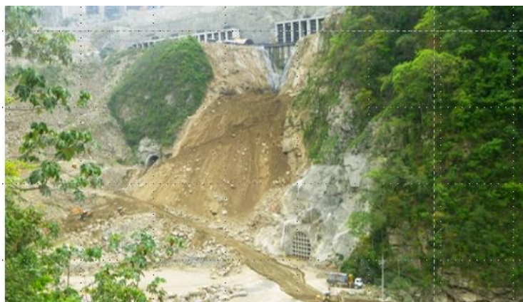
Figura 1.4. Deslizamiento del 21 de abril de 2018 (aproximadamente 25000 m 3 ) sobre el portal de entrada de la descarga intermedia
