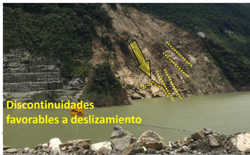
Figura 1.24 Vista de deslizamiento encima de túneles de desviación (Fuente: Equipo técnico UNAL, 2018)
