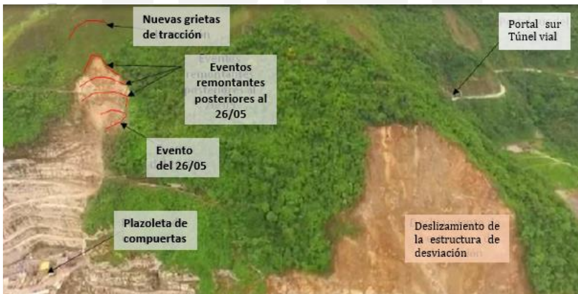
Figura 1.39. Movimientos superficiales en la margen derecha de la presa (Fuente: presentación de Integral "PH_Ituango_proceso_recuperación 7jun18).
